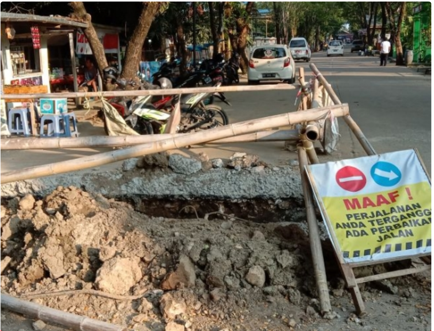
Jalan Cendana dibongkar dan belum dilanjutkan pekerjaannya
